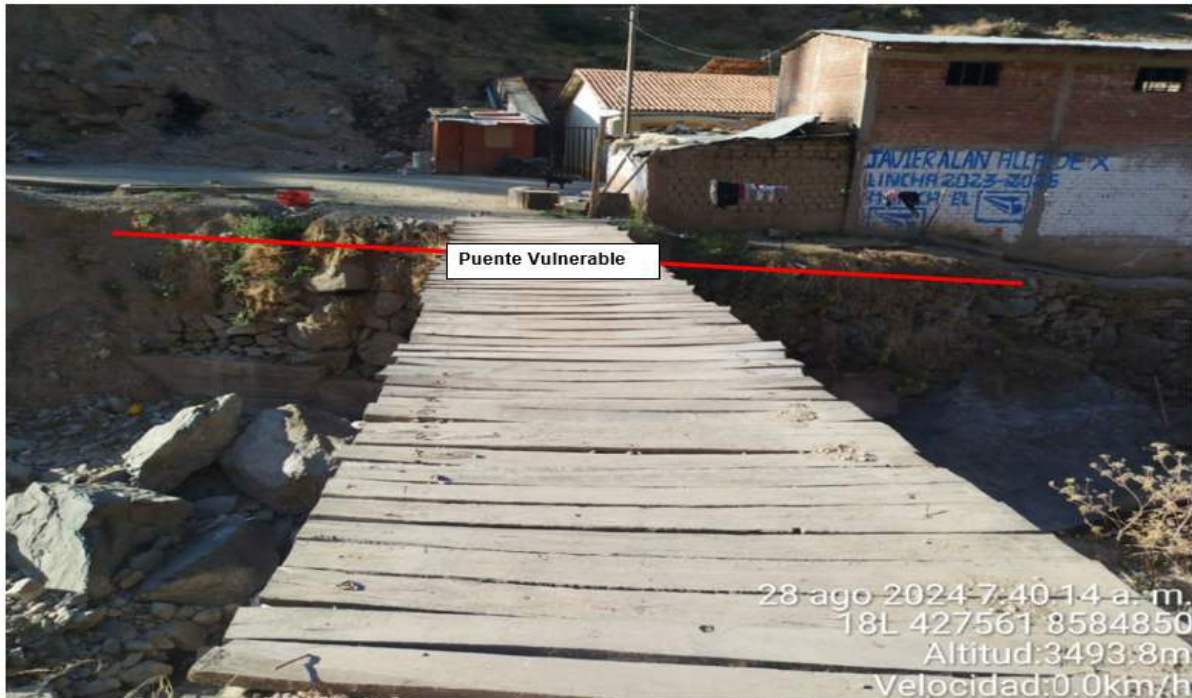
FIGURA N°02: SE OBSERVA LA MARGEN DERECHA DEL RIO EL CUAL ES VULNERABLE ANTE UNA CREDIDA, POR DICHO LADO ESTA LAS BASE DE UN PUEBLO PEATONAL.
